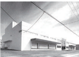
昭和55年7月 物流センター完成
